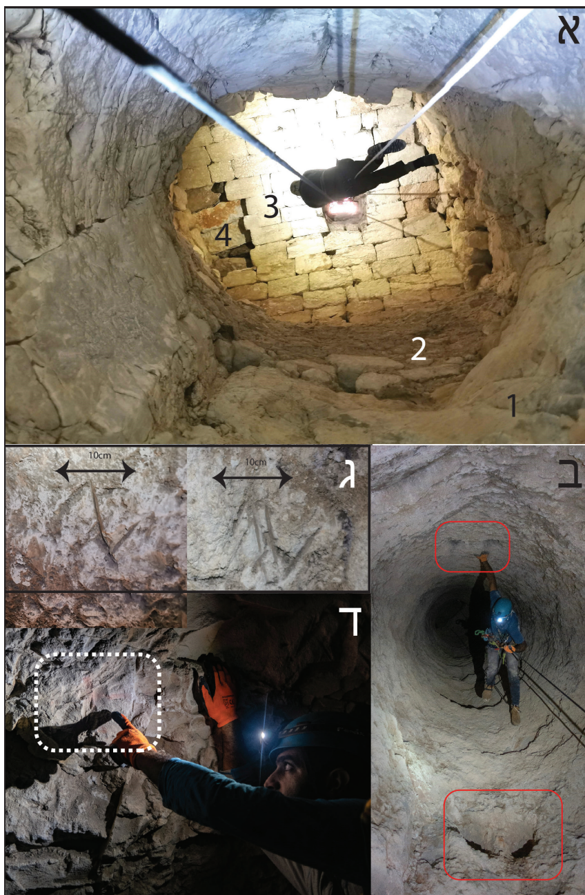
איור 5. פיר 3 במנהרת ארמון הנציב: (א) מבט למעלה לעבר ראש הפיר: סלע האם (1), קיר תמך שהושגת ישירות על סלע האם (2), קמרון חבית (3) ואבני הריצוף שהונחו מעל קמרון החבית (4) צילום: ע' יחזקאל; (ב) זוגות של נישות חצובות בדופן פיר 3 (צילום: י' נגב); (ג) תווי סתתים בדופן פיר 3 צילום: ע' יחזקאל; (ד) סימני צבע אדום על דופן פיר 3, קו מאונך וקו מאוזן מפולס למדי (ריבוע לבן מקווקו) (צילום: י' נגב)
