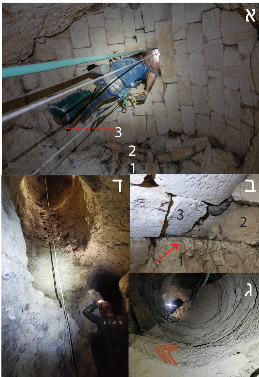
איור 6. פיר 4 במנהרת ארמון הנציב: (א) מבט לעבר ראש הפיר: סלע האם (1), קיר אבני גוויל לאיטום המרווח בין ראש הפיר (2) לקמרון החבית (3) (צילום: י' נגב); (ב) הגדלה של הריבוע האדום באיור 6א: סלע האם (1), קיר אבני הגוויל (2), קמרון החבית (3) ושכבת הטיח הלבן העבה שהושתתה על סלע האם ושהפיר חתר (חץ אדום) (צילום: י' נגב); (ג) פיר 4 מבט למטה: דגם החציבה של הפיר מסומן בקווים אדומים: רגיסטים היוצרים דגם הידרה. (ד) מבט דרומה לעבר בסיס פיר 4, הפיר אינו ממורכז ביחס לתוואי המנהרה (צילום: ע' יחזקאל)
