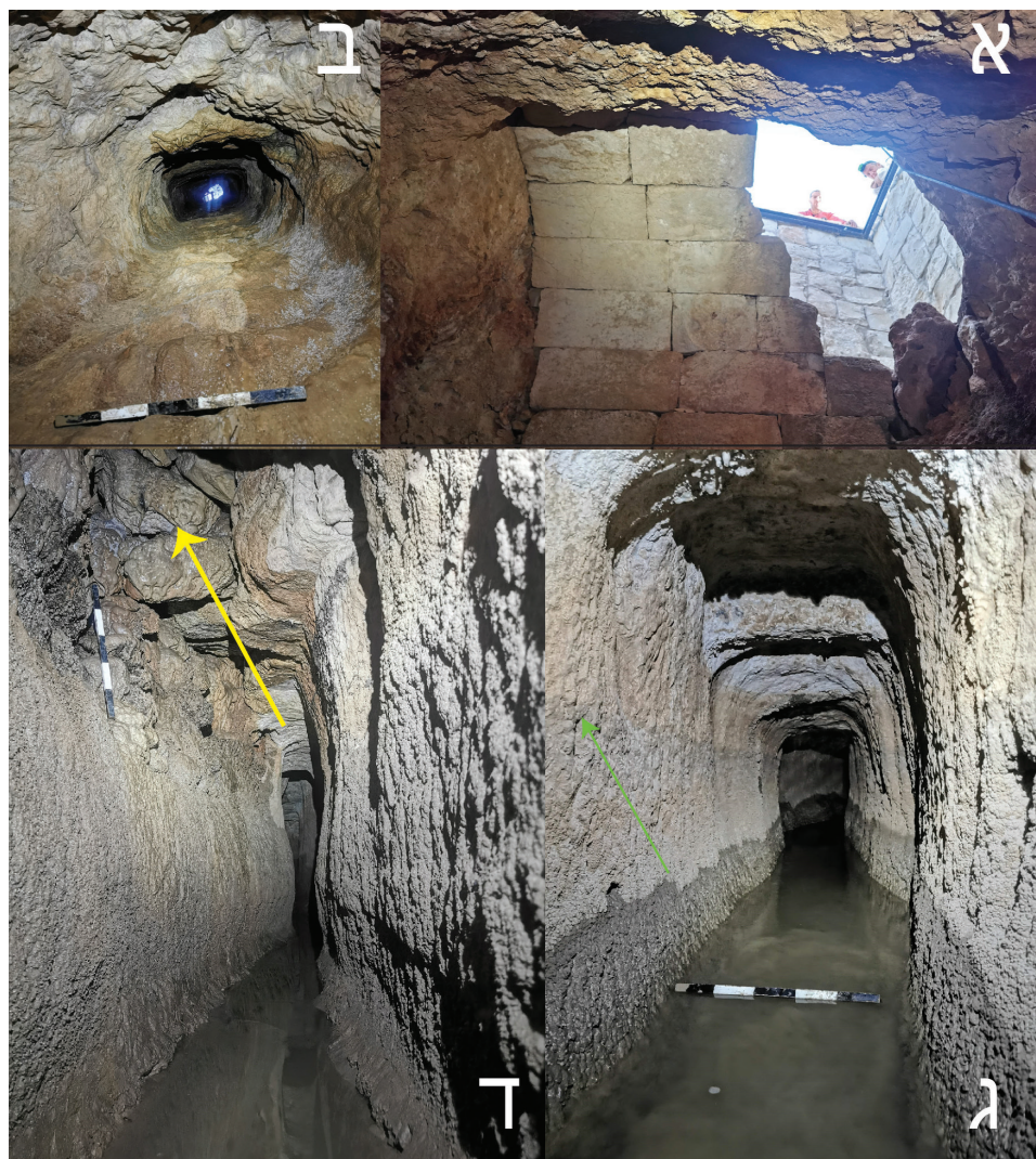
איור 12. אמת הביאר לירושלים, מנהרת דהר בקו (צילום: ע' יחזקאל): (א) קמרון חבית שכיסה את ראש פיר 7, מבט מלמטה; (ב) מבט כלפי מעלה בפיר מספר 5, ובו מדרגות ולו חתך מלבני; (ג) פנים המנהרה, ובו אפשר לראות את מפלס המים וקו הרטיבות (חץ ירוק); (ד) זרימת מים מתוך סדק קרסטי בתקרת המנהרה (חץ צהוב)
